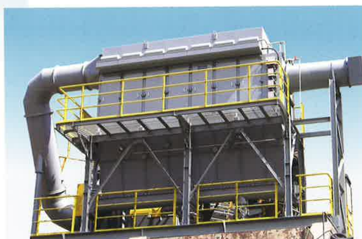
採石所環境集塵 型式：HSL-1500-56/18-KH 処理風量：500m 3 /min W：5400mm H：2600mm D：1600mm
