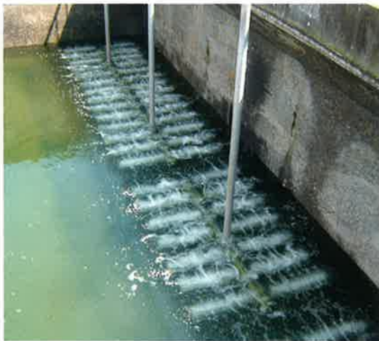
試運転状況(発泡検査)
